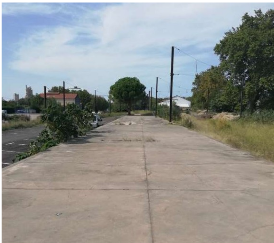
Ancienne friche SNCF. Vue d'est.
